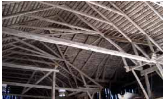
Bärande stolpkonstruktion i logen.
